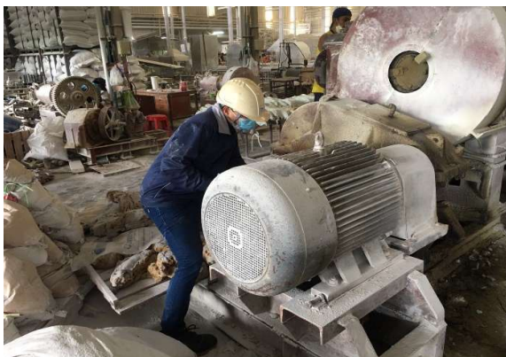
รูปภาพก่อนปรับปรุง
