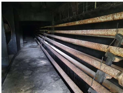
รูปภาพก่อนปรับปรุง
