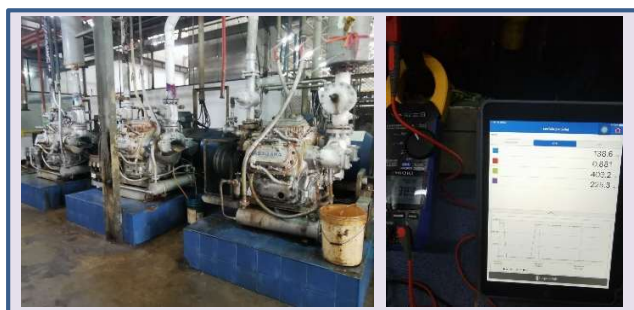
รูปภาพก่อนปรับปรุง
